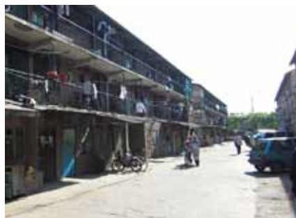
民工所居住的破舊樓房
